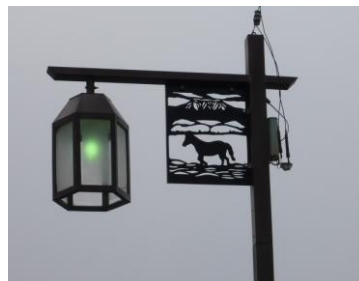
光が上部へ漏れる従来の防犯灯
